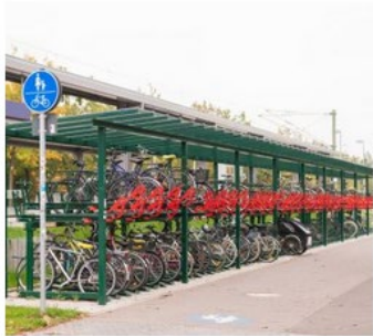
Quelle: Bildkraftwerk / Laurin Schmid
