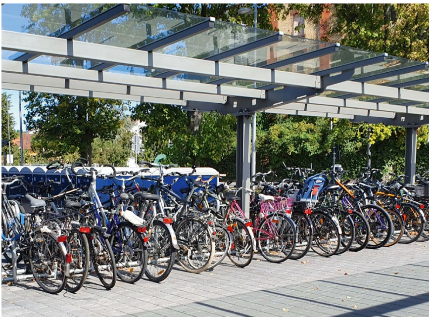
Überdachte Bügelhalter in wechselnder Hoch-/Tiefaufstellung am Bahnhof Lahr
