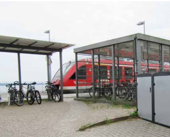
Sammelschließanlage am Bahnhof in Plön
