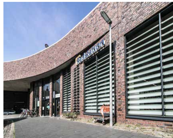
Eingangsseite der Radstation in Bergedorf
